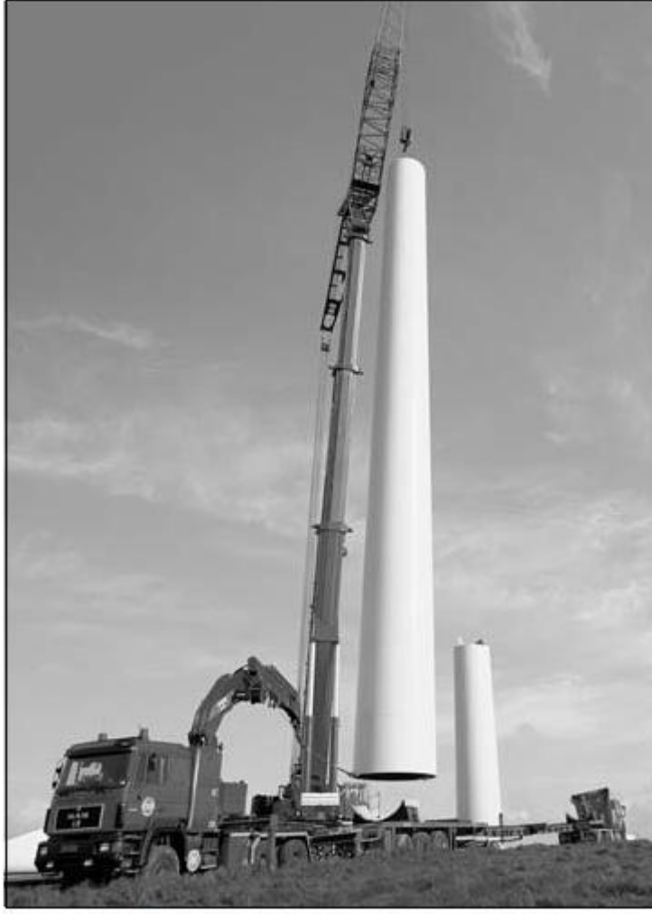
الشكل رقم (٢٦) : رفع البرج لتركيبه على القاعدة
