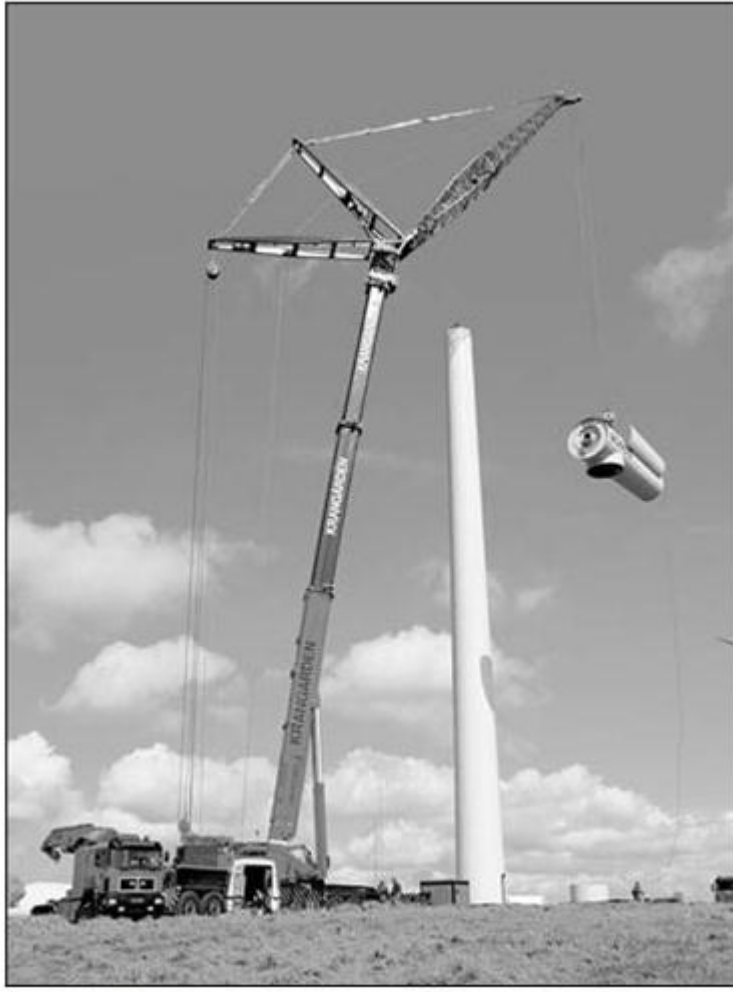
الشكل رقم (٢٨) : رفع الناسيل الى قمة البرج
