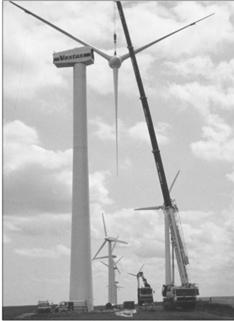
الشكل رقم (٢٥) : تجميع الريش على الارض ورفعها
