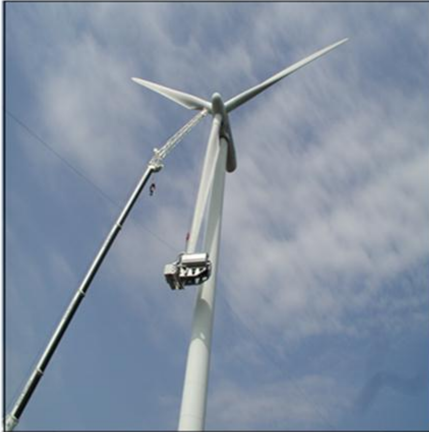
الشكل رقم (٨) : تنفيذ عملية غسيل الريش
