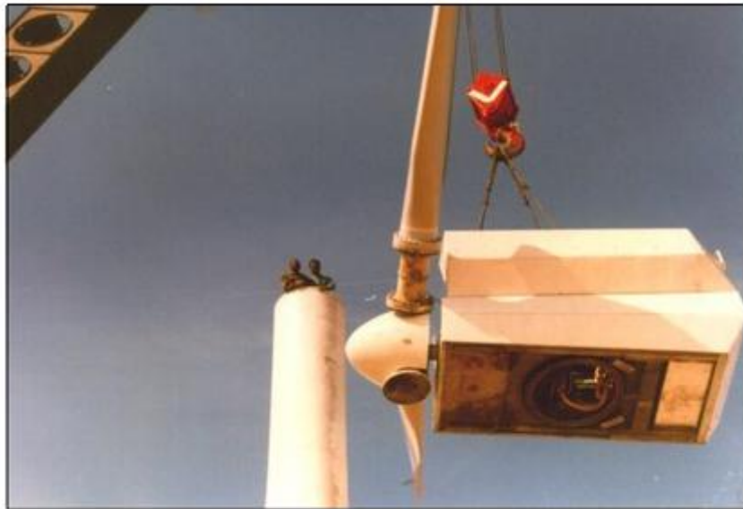
الشكل رقم (٢٤) : رفع الناسيل فوق البرج
