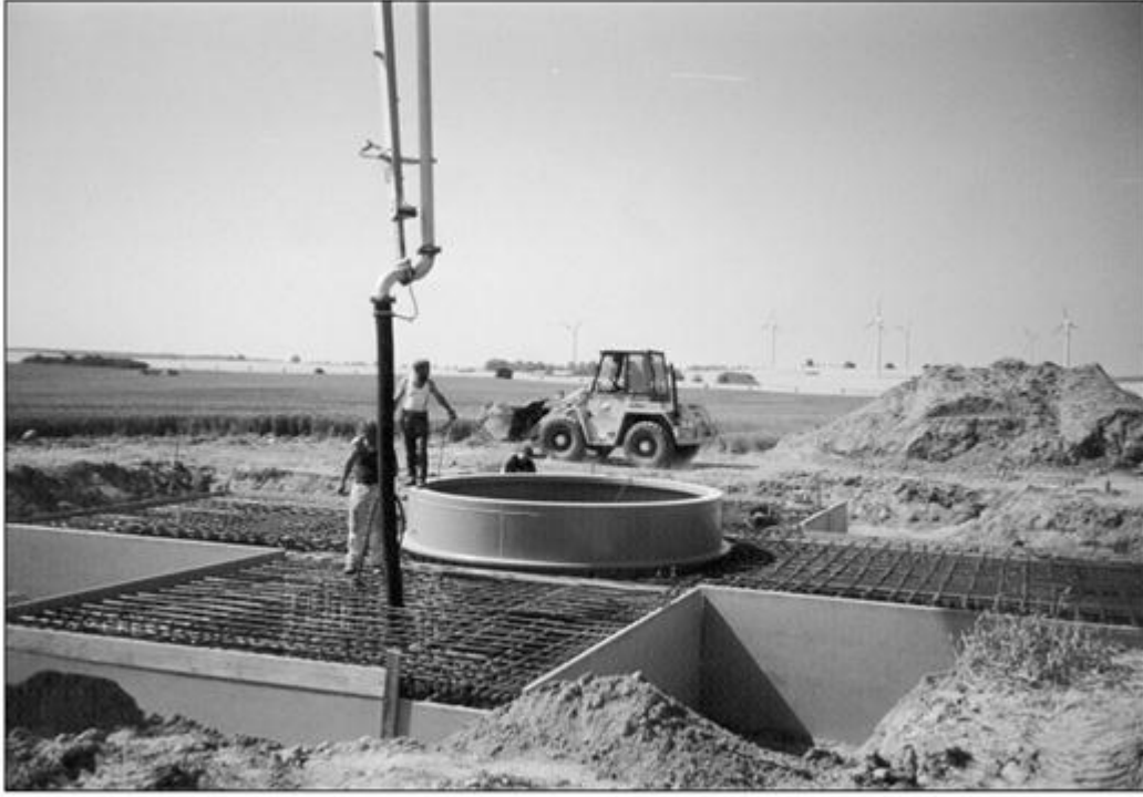
الشكل رقم (٥٢) : تنفيذ القاعدة الخرسانية
